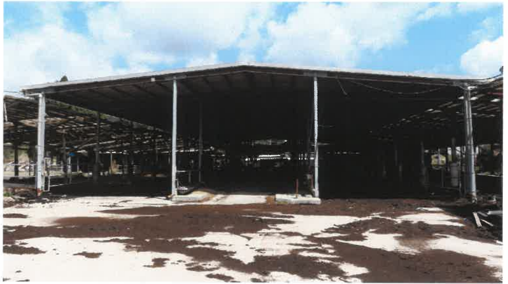
物件 5 2 建物 (南側)
