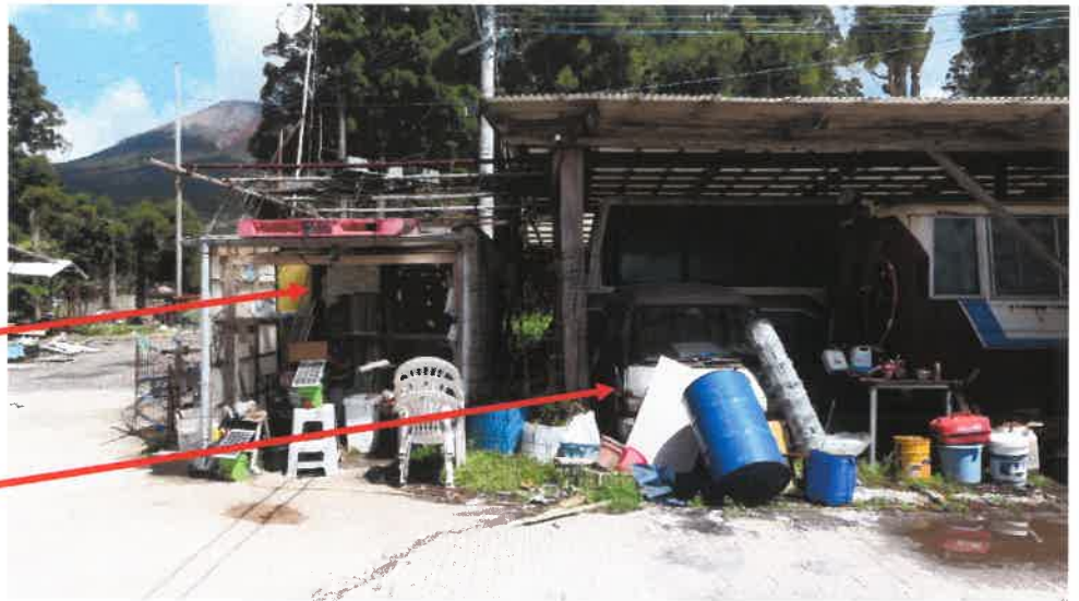
物件3 1 未登記附属建物7 (堆肥舎)
