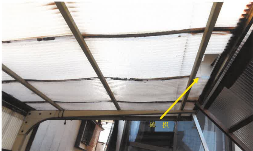
カーポート 屋根の状況
