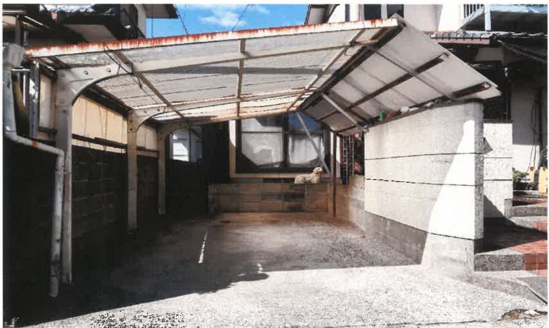
カーポートの状況
