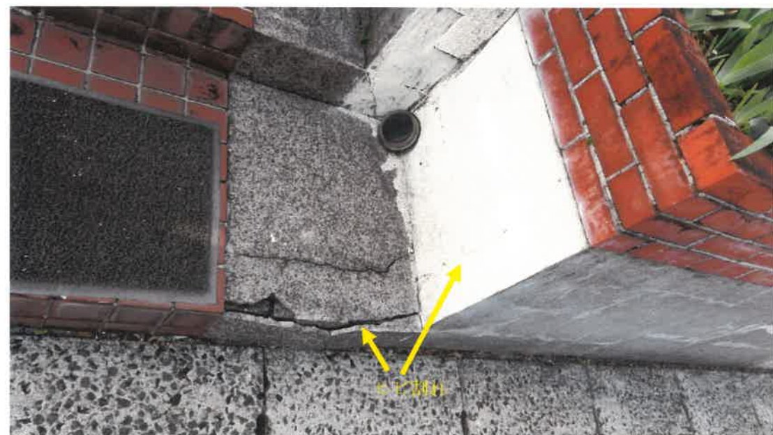
門扉付近の 状況
