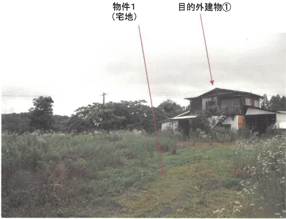
北東方より物件1をのぞむ
