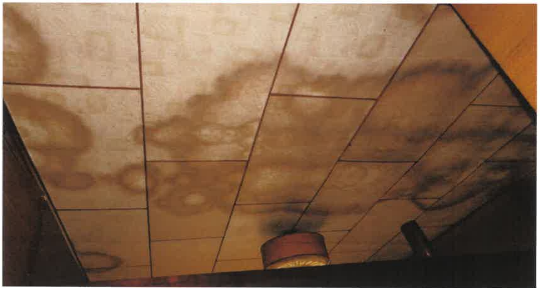
玄関天井付近の雨漏り跡の状況
