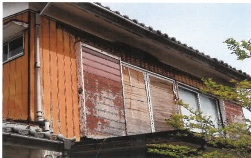
雨戸等の状況 (2階部分)
