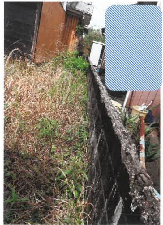
写真㉑ ブロック積の状況
