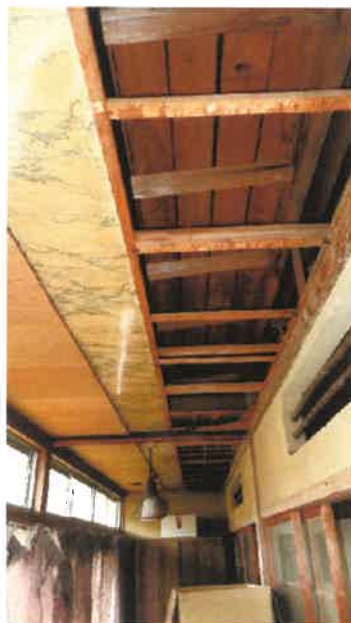
玄関天井付近の雨漏り跡の状況
