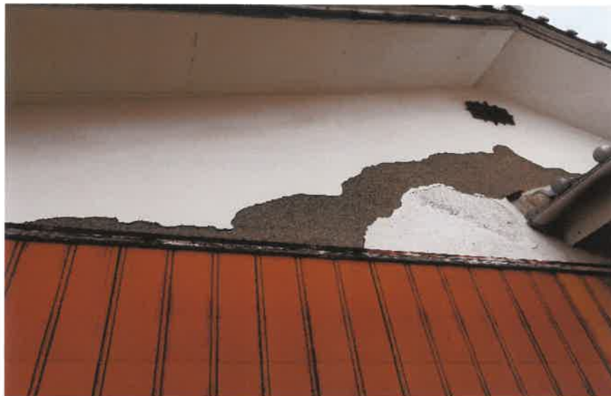
南東側 外壁の状況
