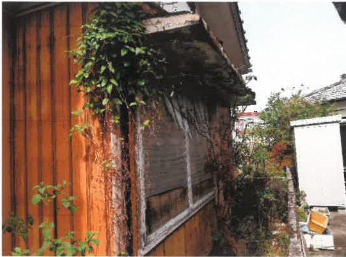
南東側部分の状況
