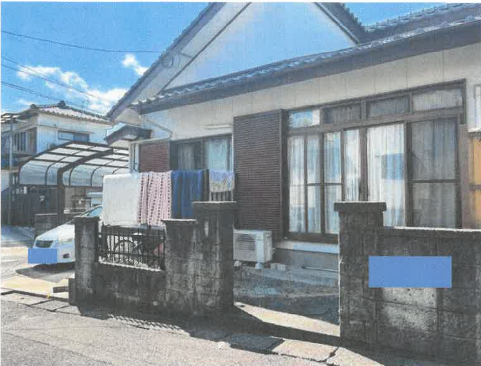
写真② 南東方より
