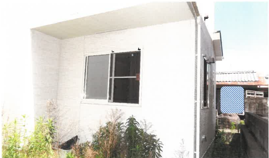
物件3建物 南東側
