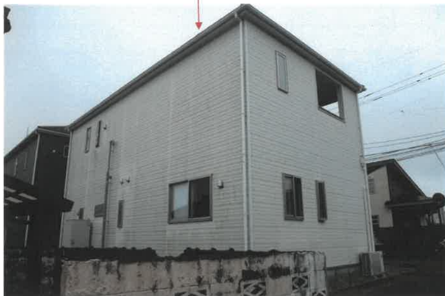
北西方よりのぞむ
