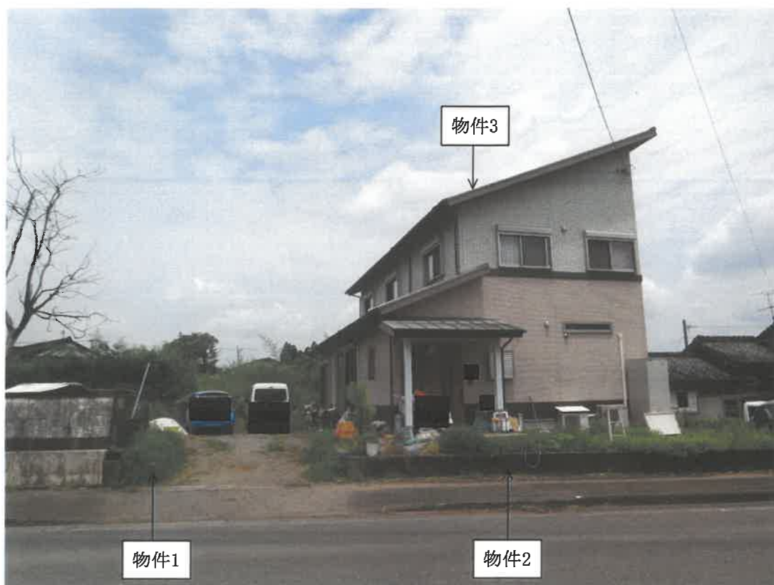
現況写真 南東方から撮影
