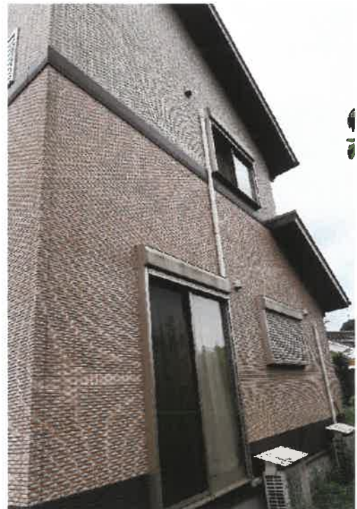
物件3建物 北西側
