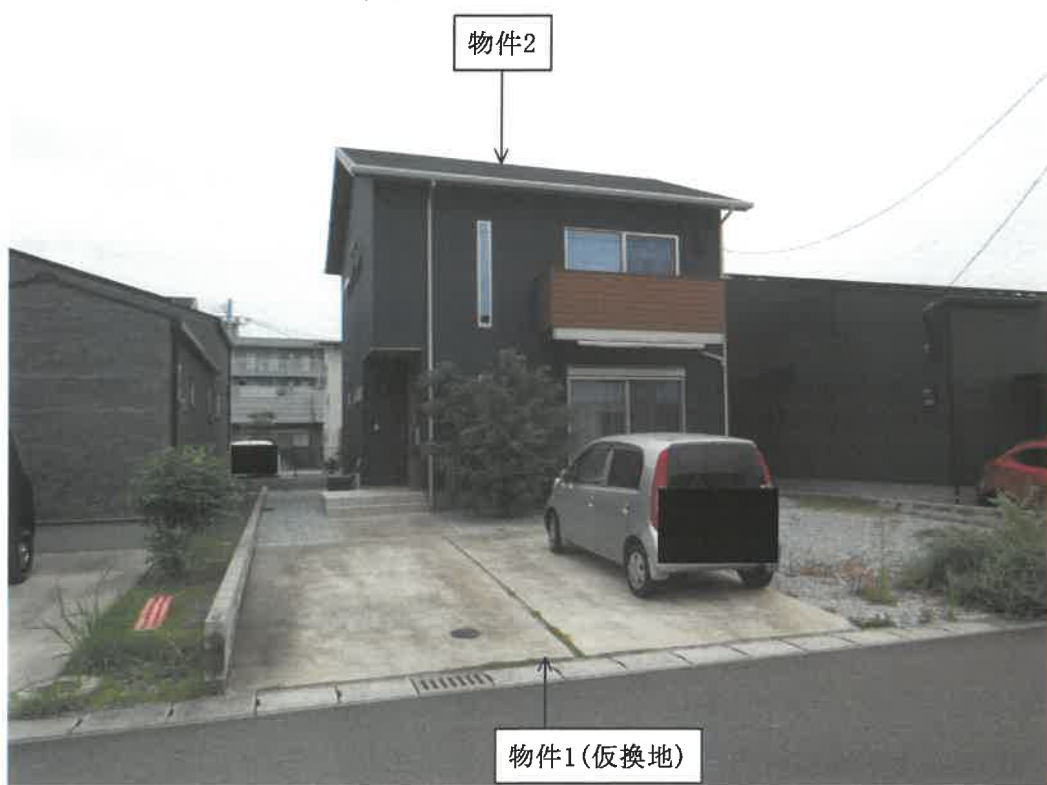
現況写真 南西方から撮影
