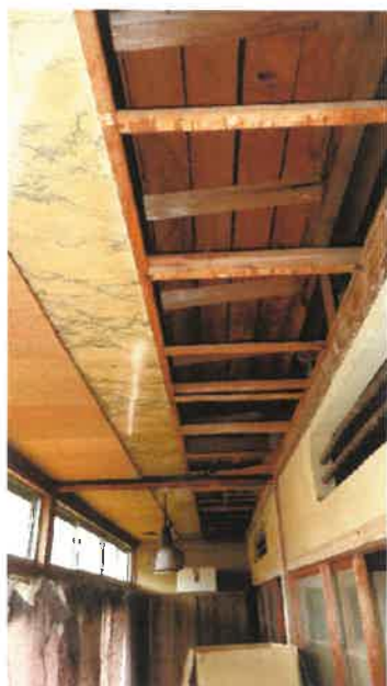
玄関天井付近の雨漏り跡の状況
