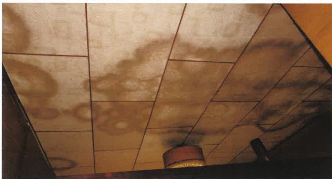
玄関天井付近の雨漏り跡の状況
