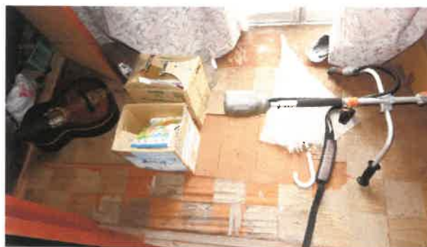
くれ縁床の状況
