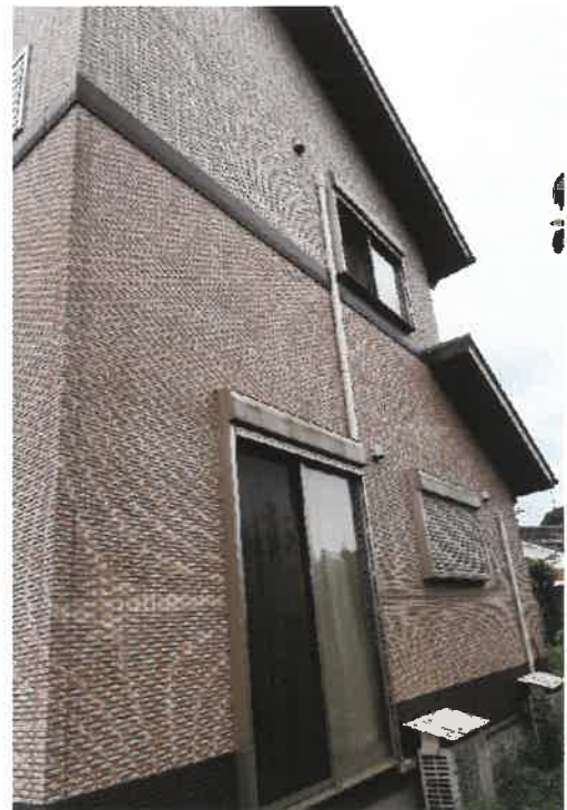
物件3建物 北西側
