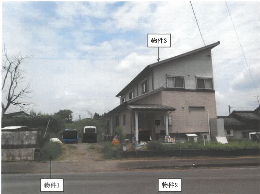
現況写真 南東方から撮影
