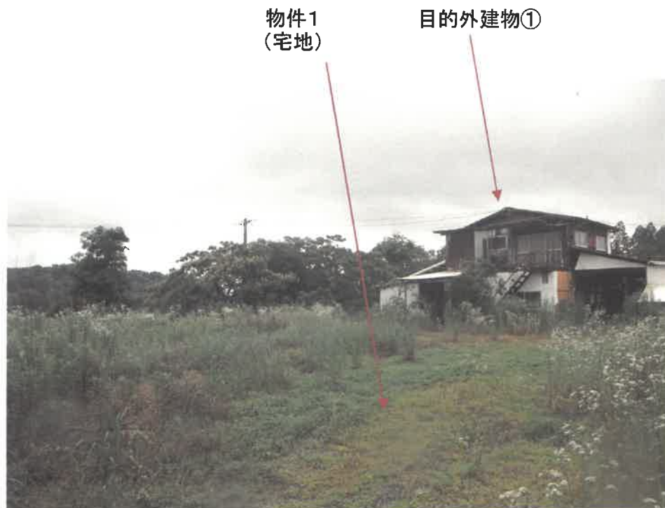
北東方より物件1をのぞむ
