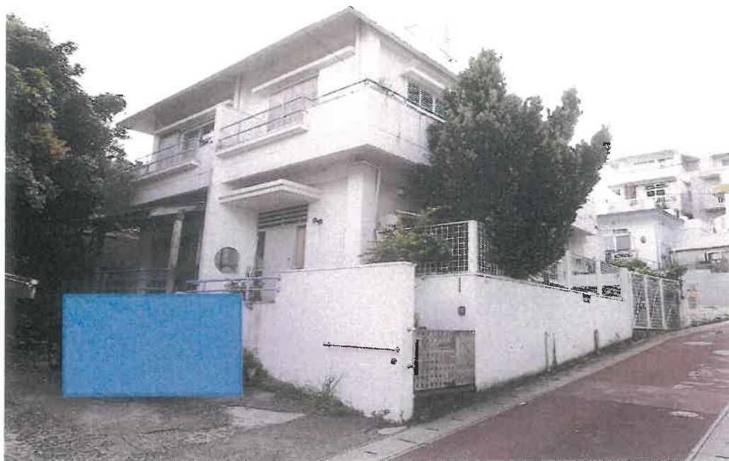
本件建物全景
