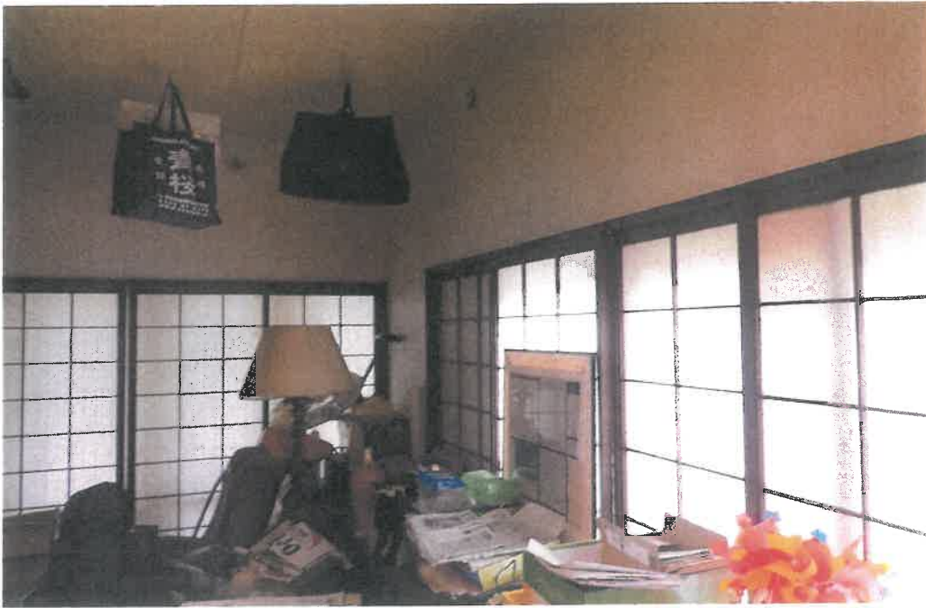
本件建物内部
