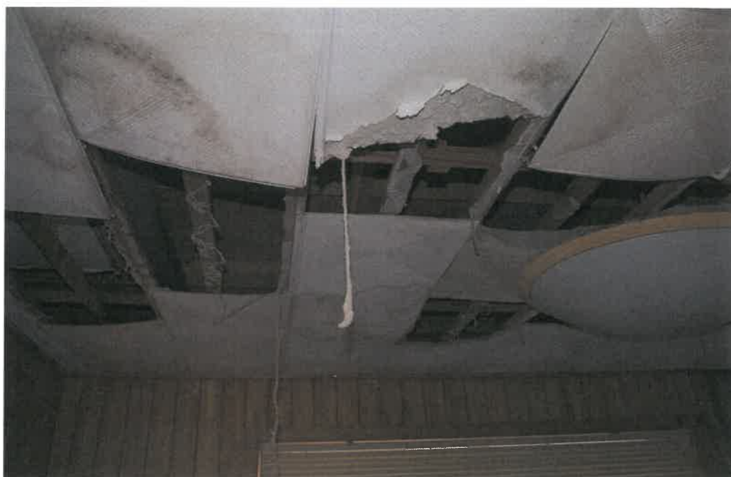
物件2の室内(1階:増築部分の天井)
