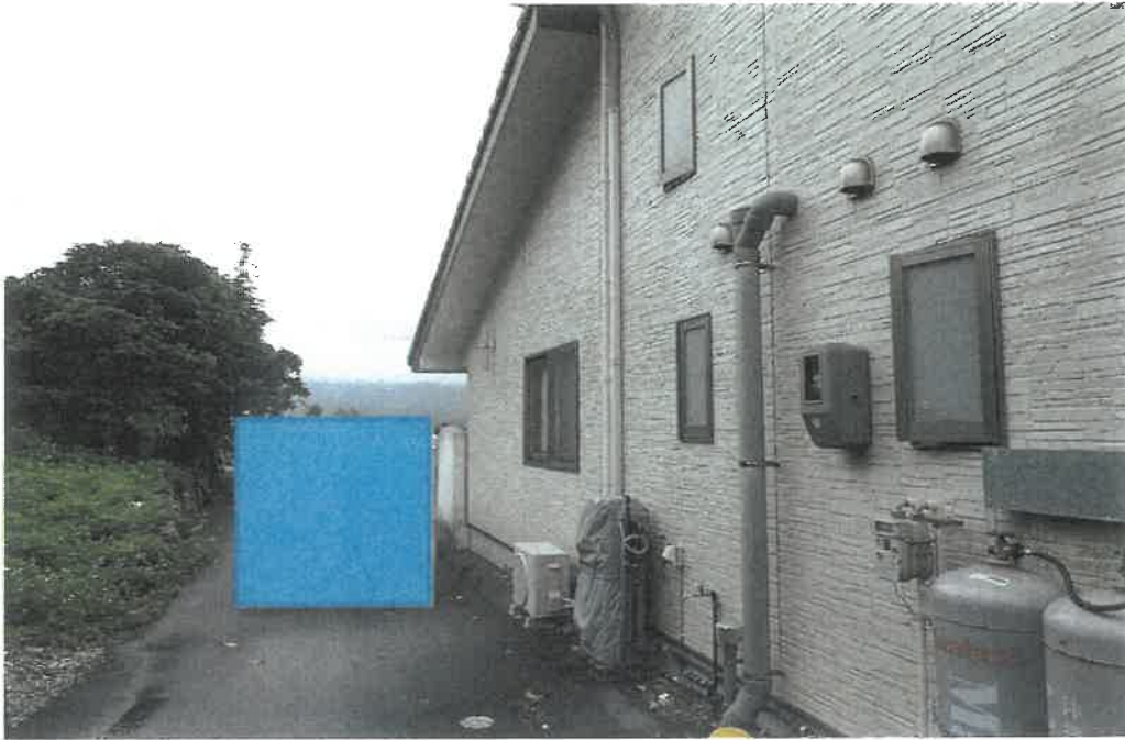
物件7及び同8の通路の状況
