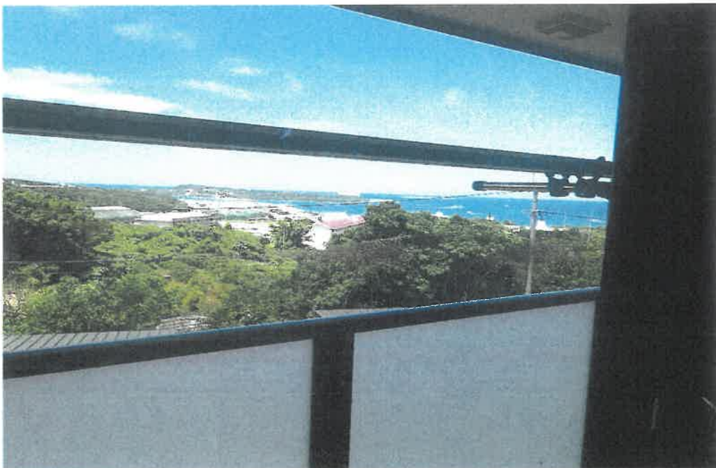
物件8ベランダの状況
