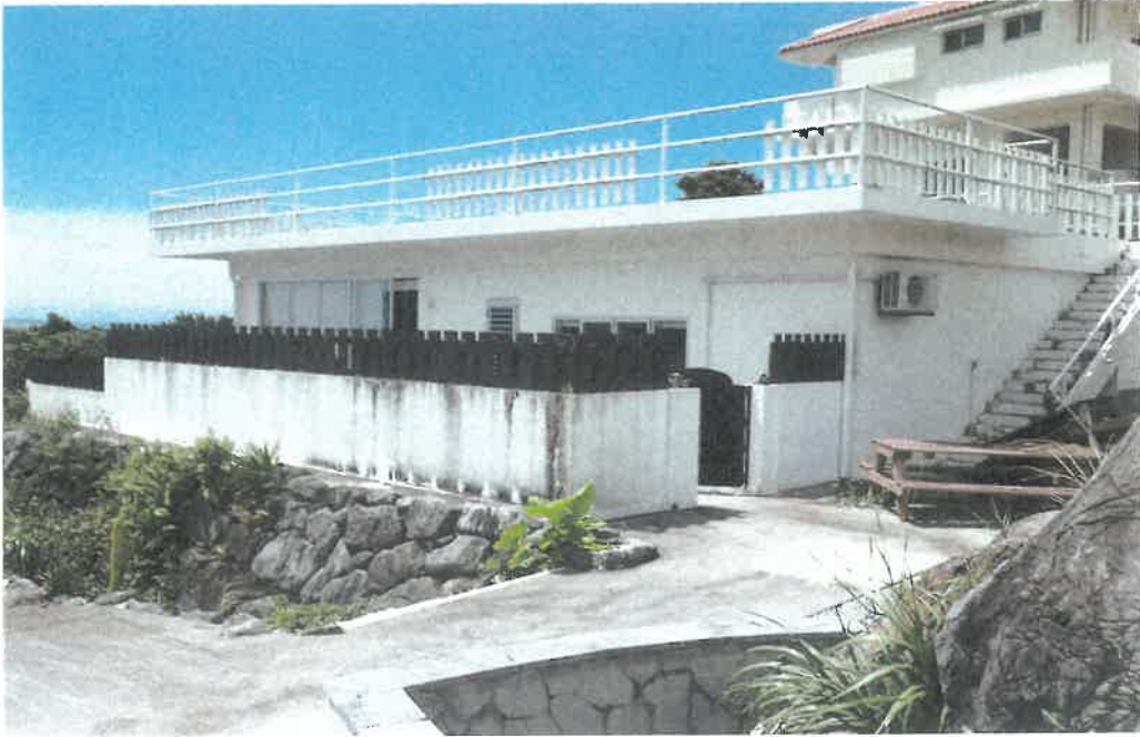
本件建物全景
