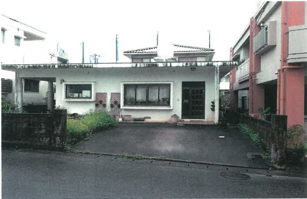
本件建物全景
