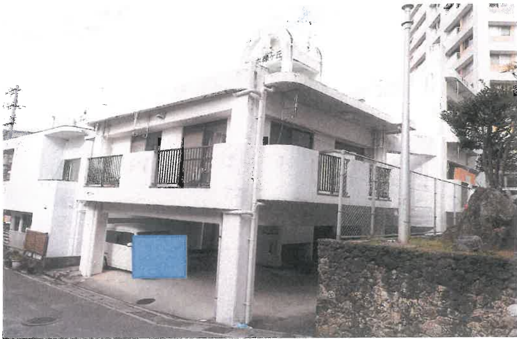
本件建物全景
