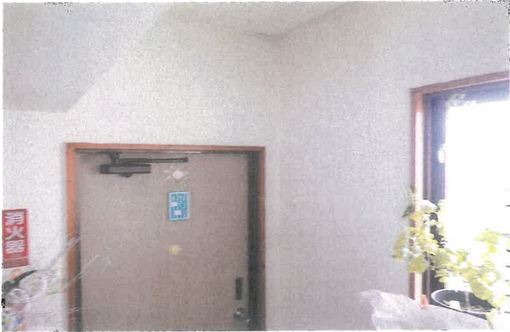
本件建物内部(301)
