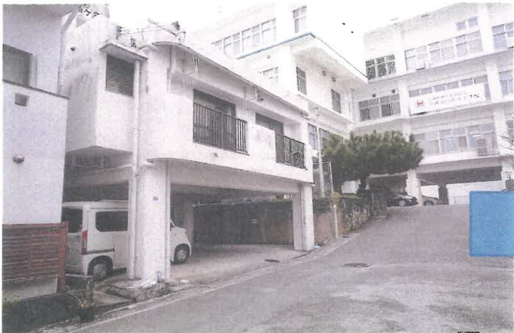
接面道路の状況
