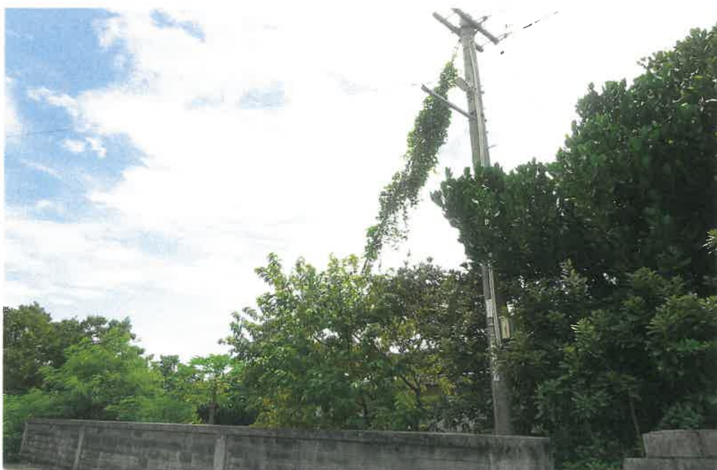
物件1にある電柱
