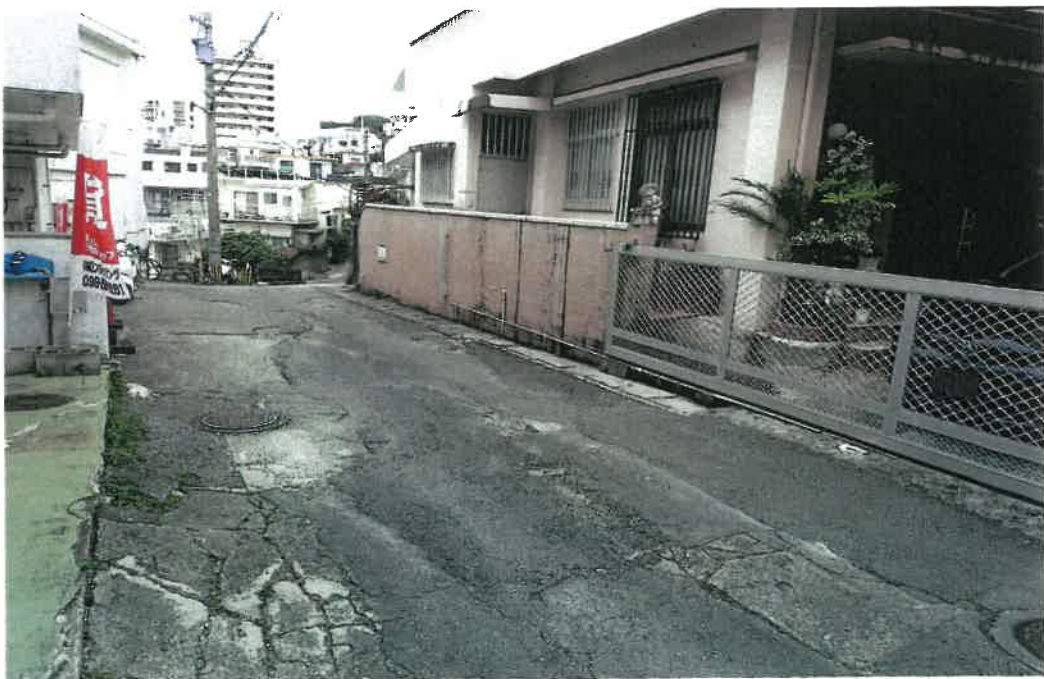
接面道路の状況
