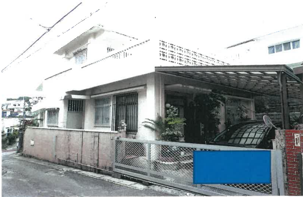
本件建物全景
