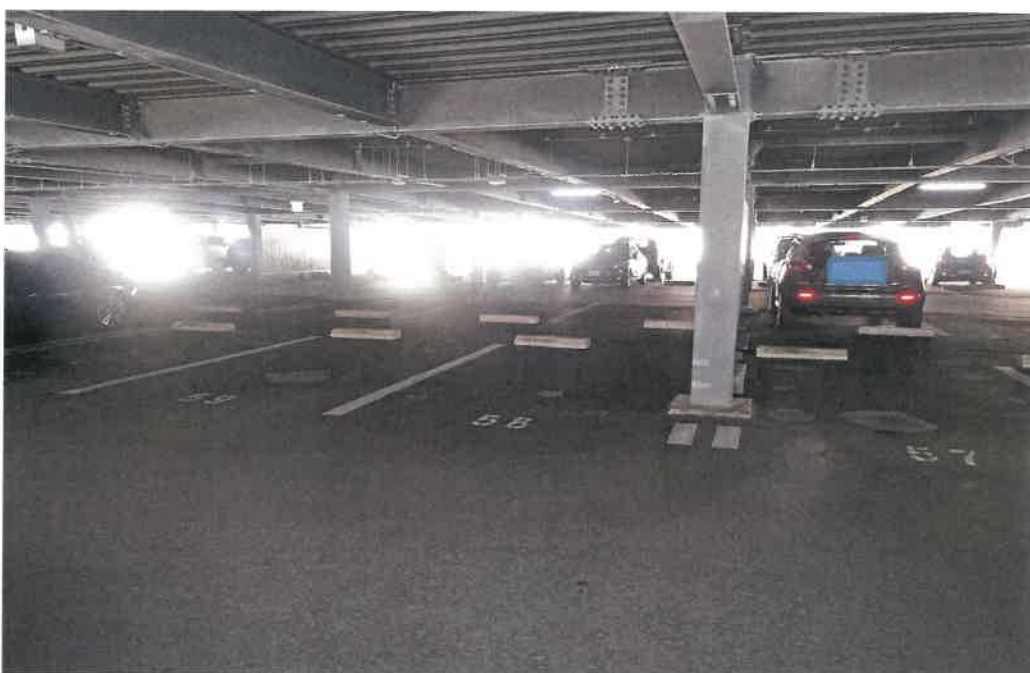
自走式立体駐車場
