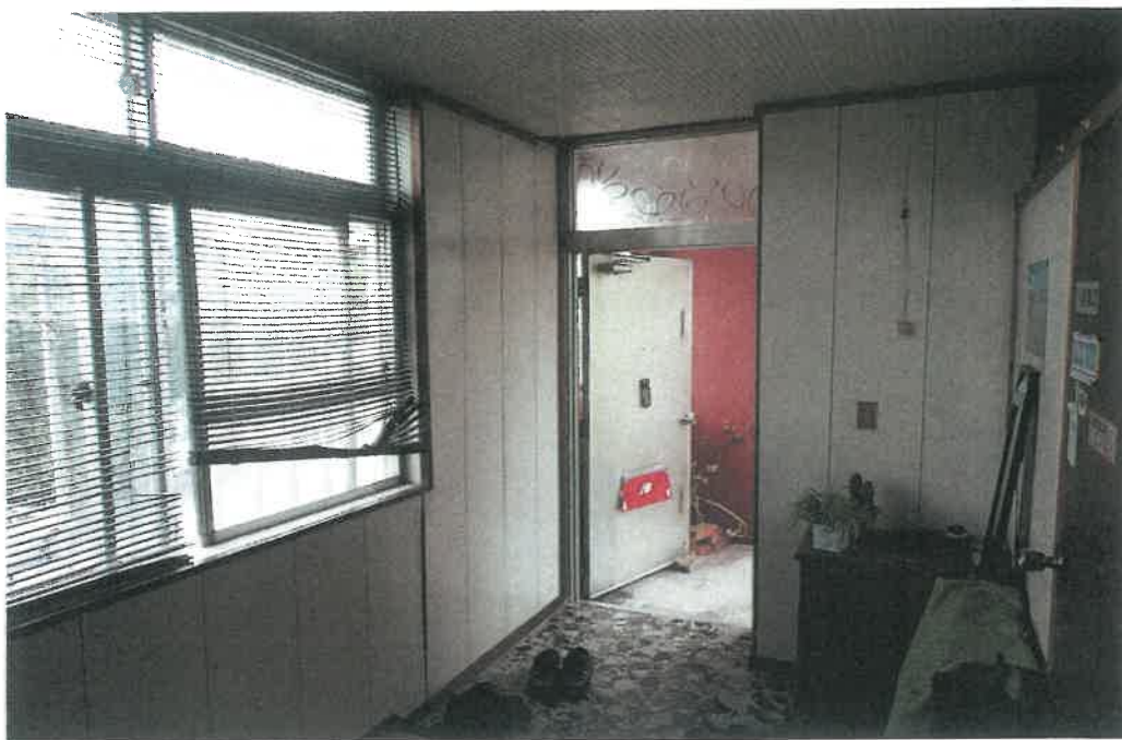
本件建物内部(3階)
