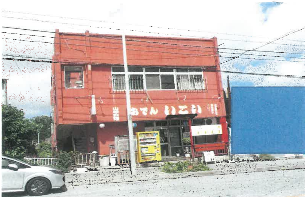
本件建物全景
