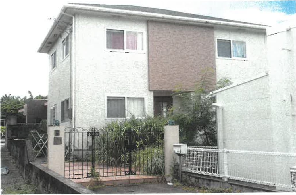
本件建物全景
