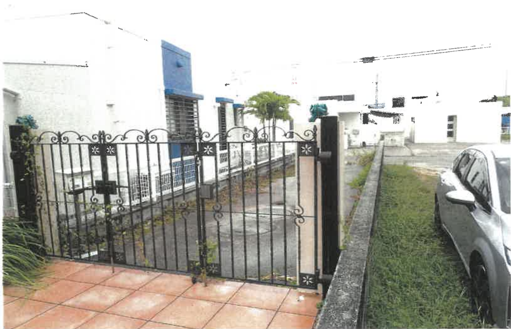
進入路等の状況
