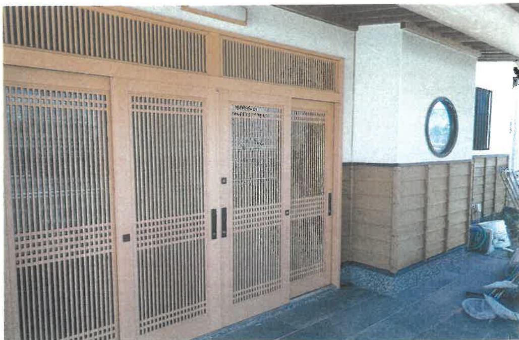
本件建物玄関付近の状況
