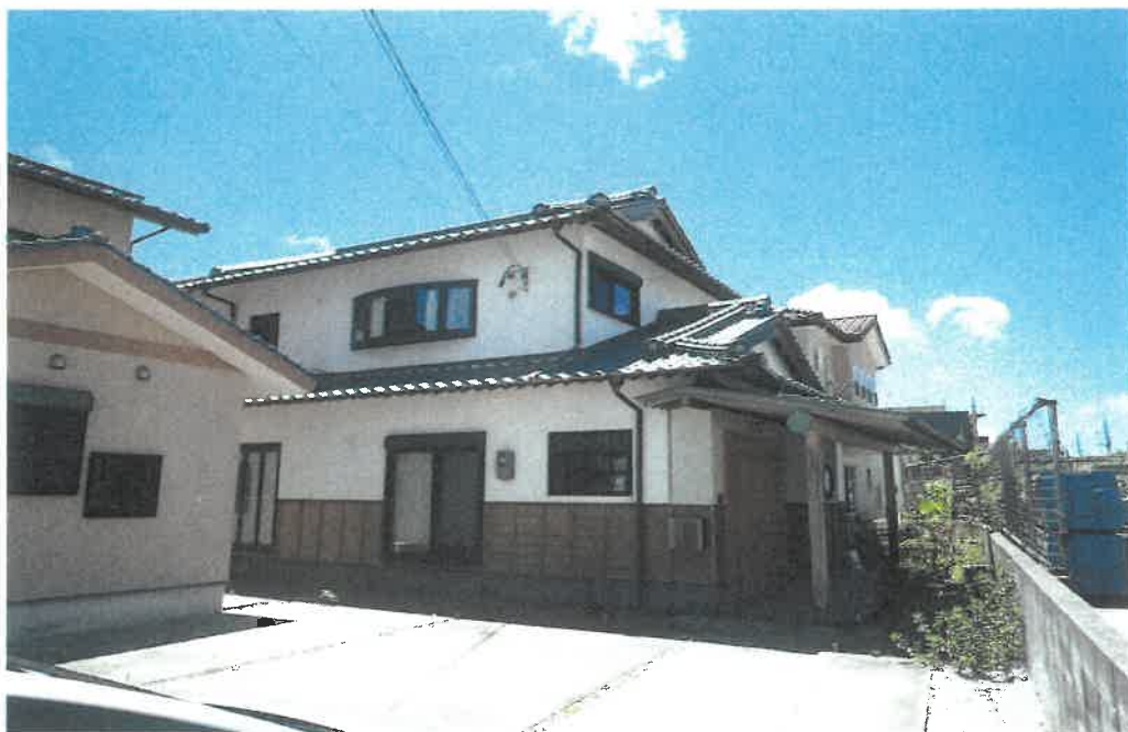
本件建物全景
