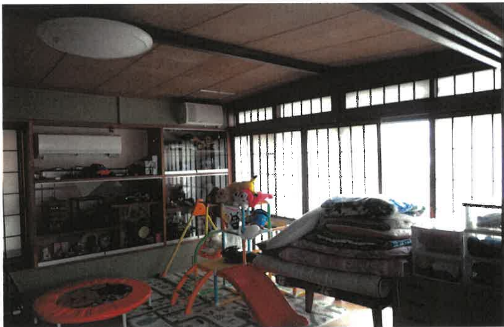
本件建物内部
