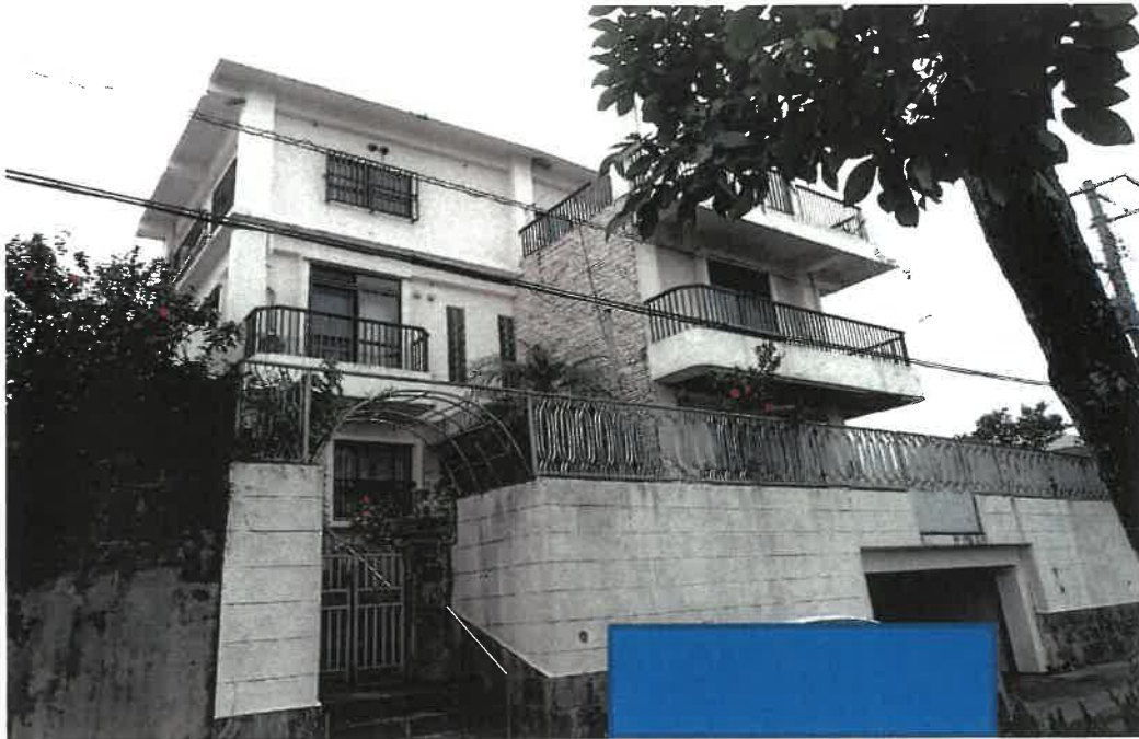
本件建物全景
