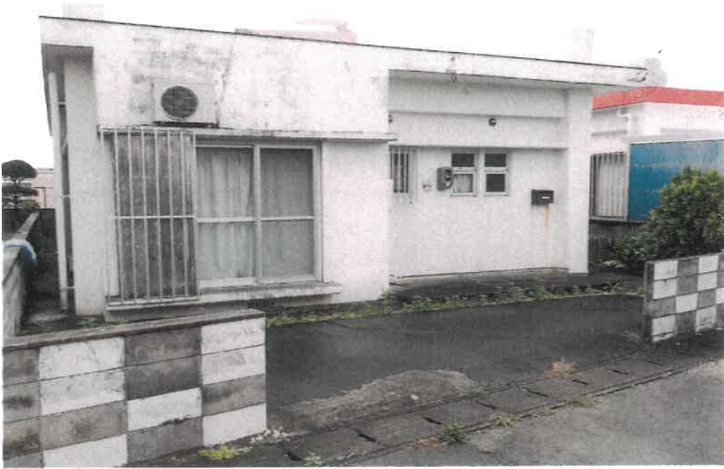
本件建物全景
