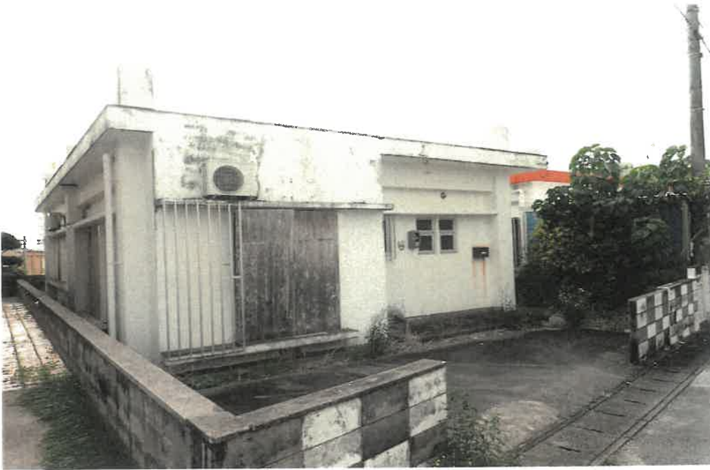
本件建物全景
