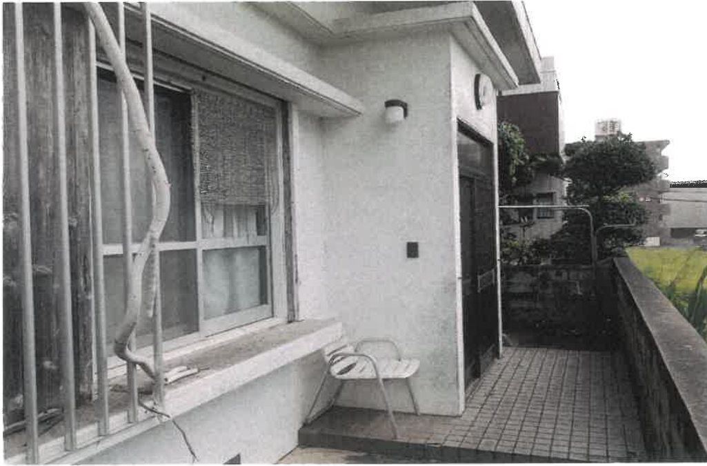
本件建物玄関(接面道路の反対側)の状況
