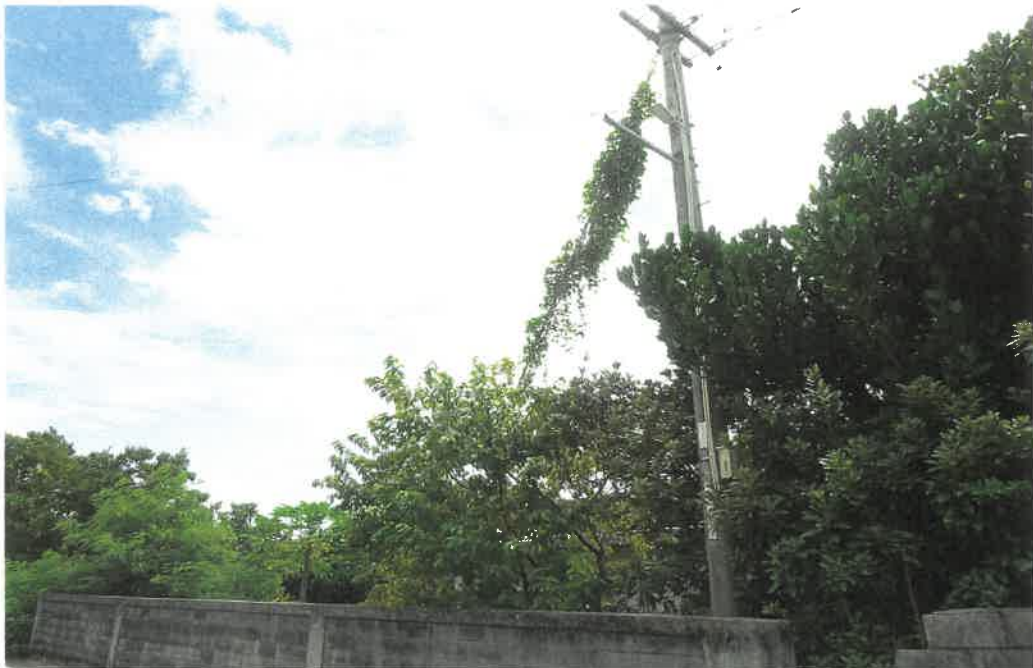
物件1にある電柱
