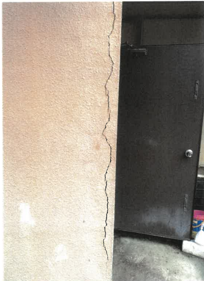
コンクリート壁の亀裂の状況
