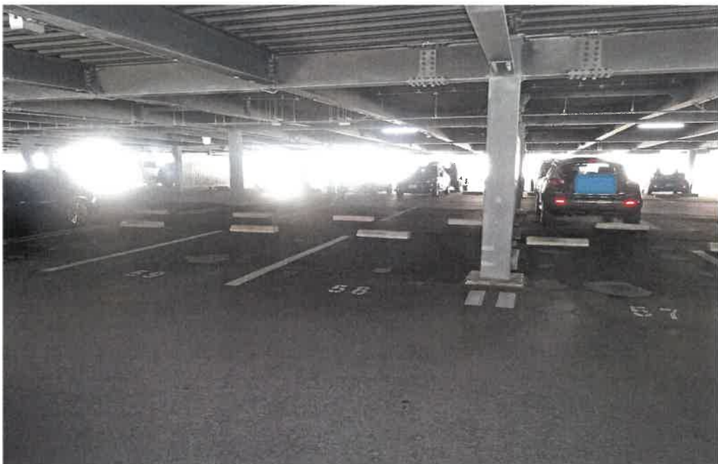
自走式立体駐車場
