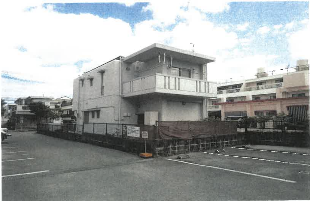
隣地との境界付近の状況
