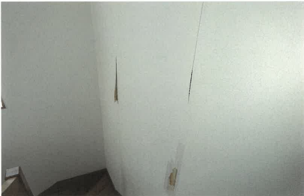
物件2(壁紙の剥がれた箇所)
