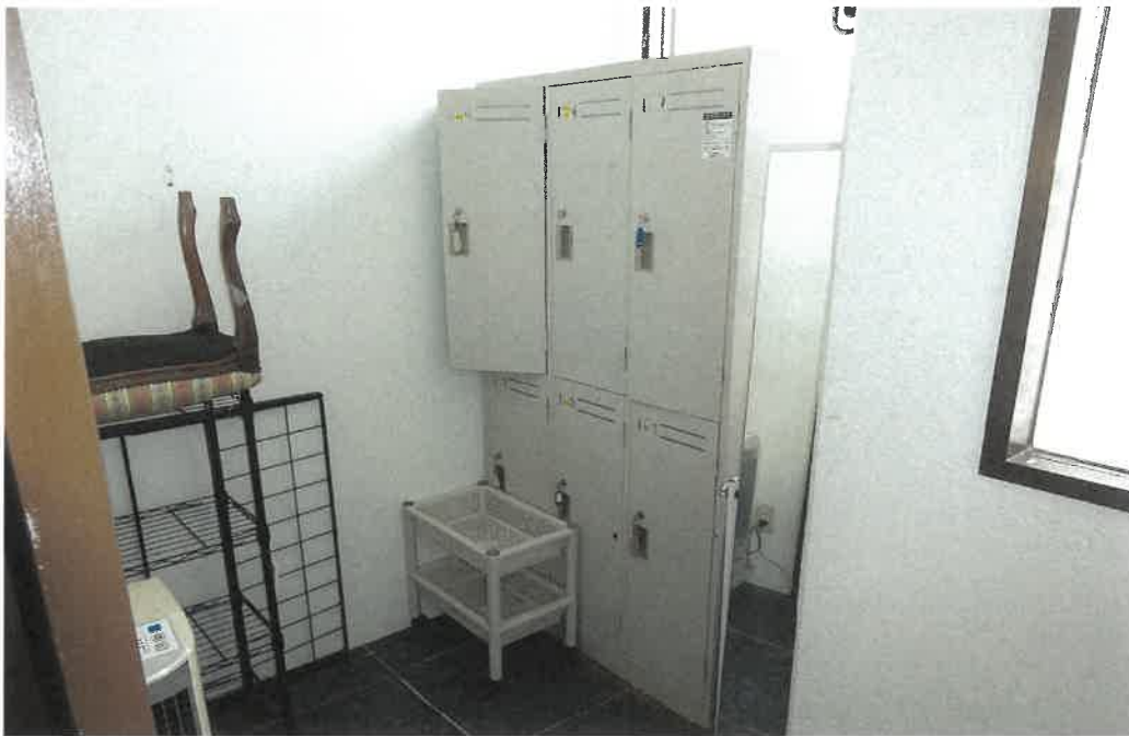
共用部分にある増築箇所
