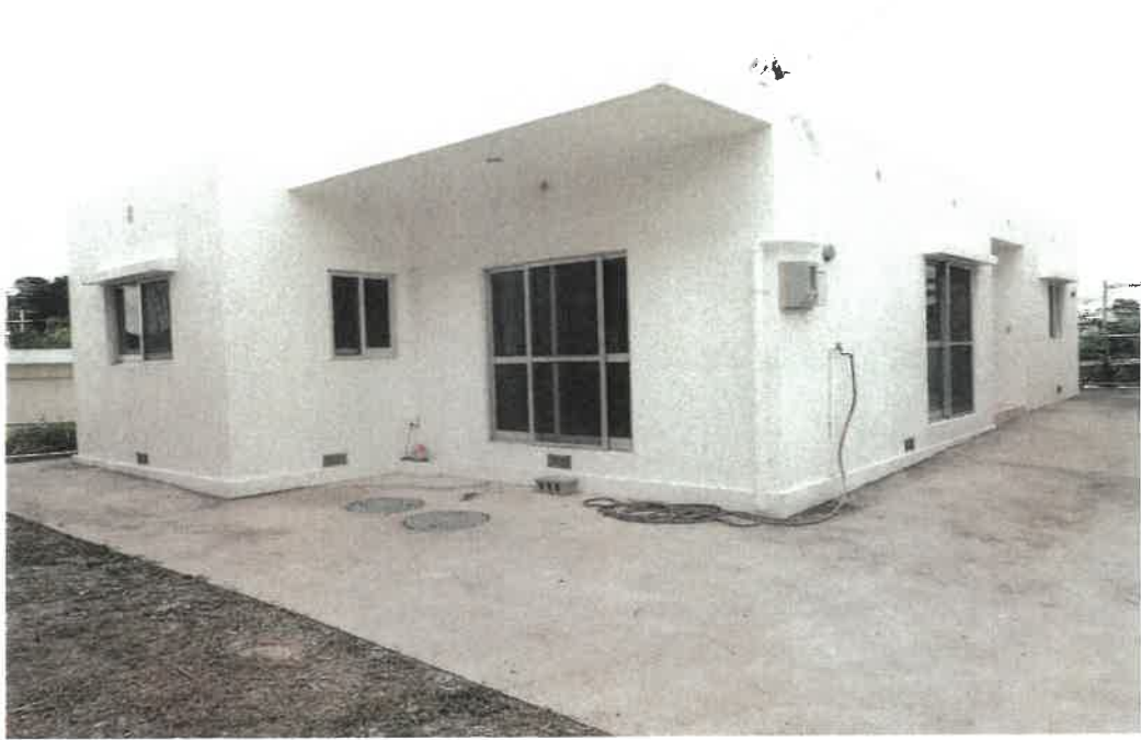
本件建物全景
