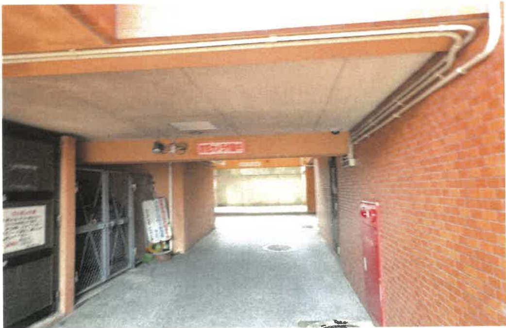
駐車場付近の状況
