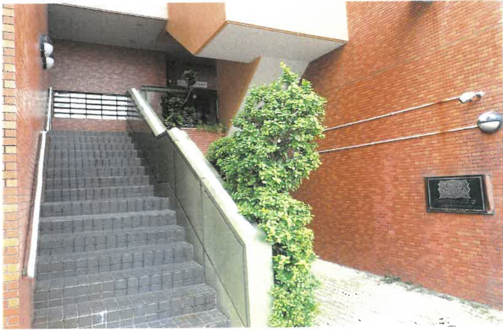
本件建物を含む一棟の建物入口付近の状況
