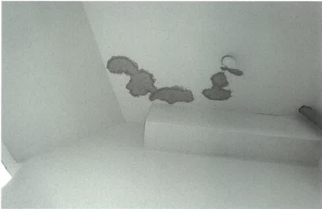
コンクリートの補修箇所
