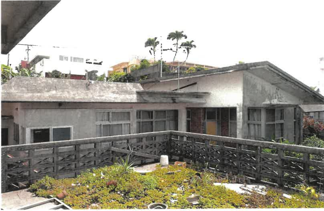
本件建物全景
