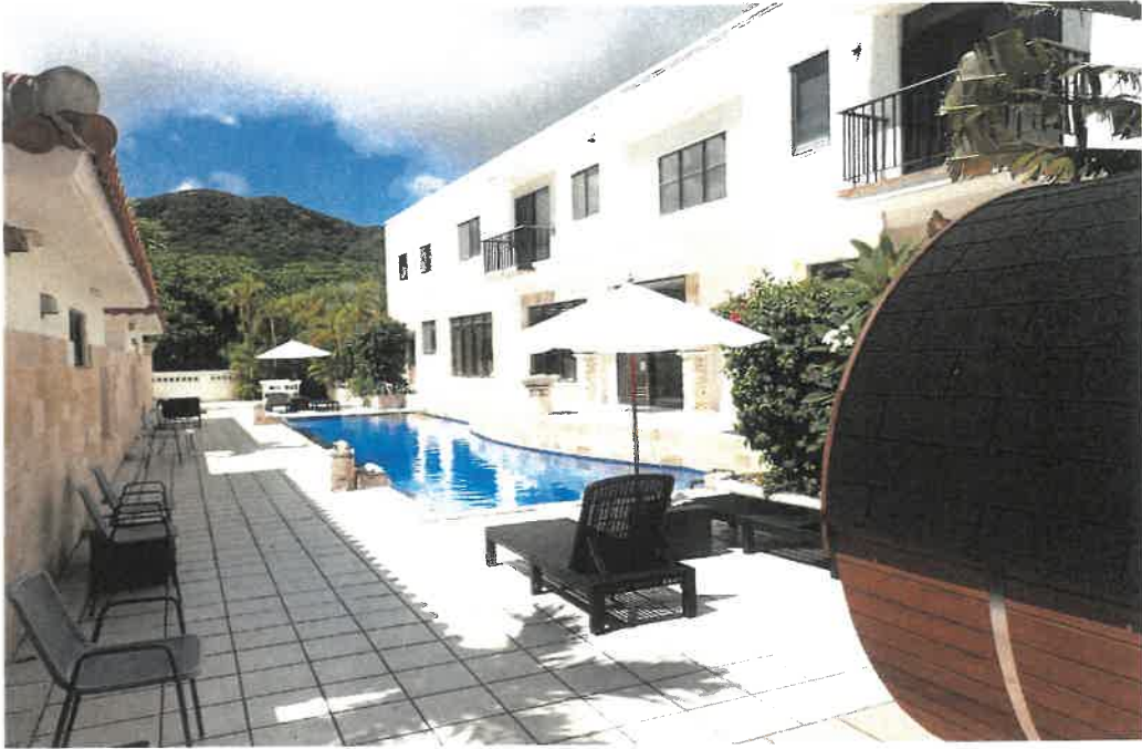
物件3 建物全景
