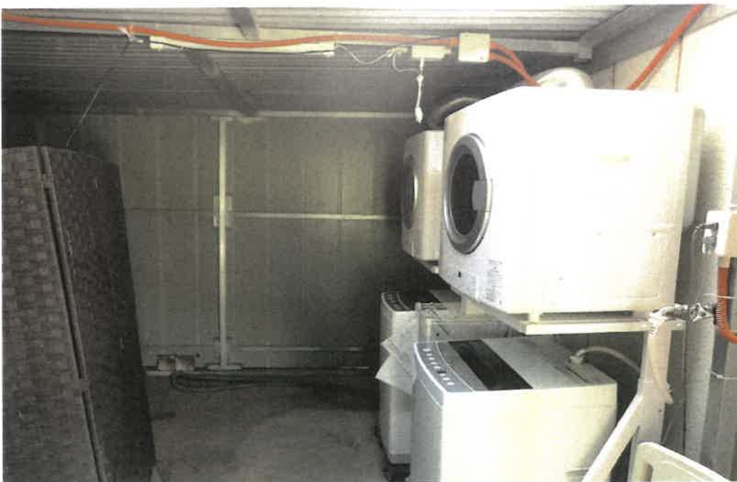
未登記附属建物内部
