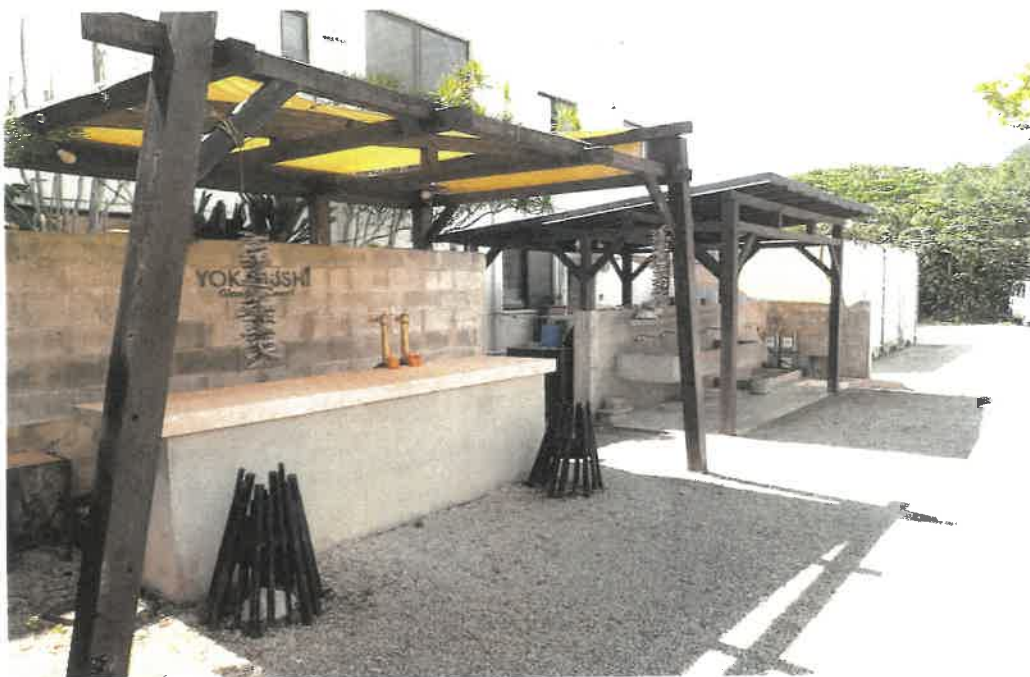
バーベキューエリアの状況
