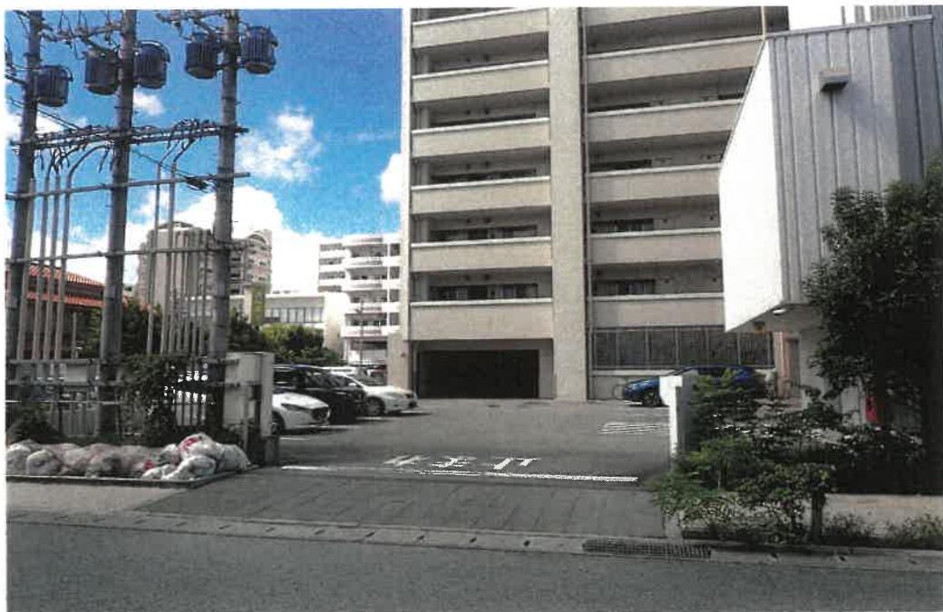
駐車場入口付近の状況
