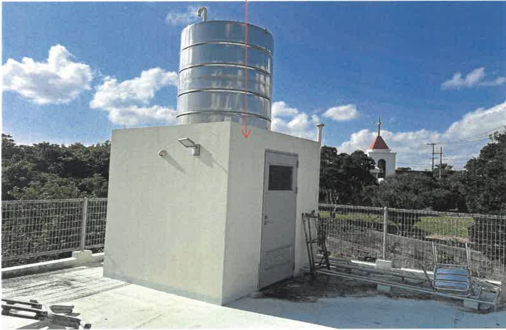
水装置室(附属建物)
