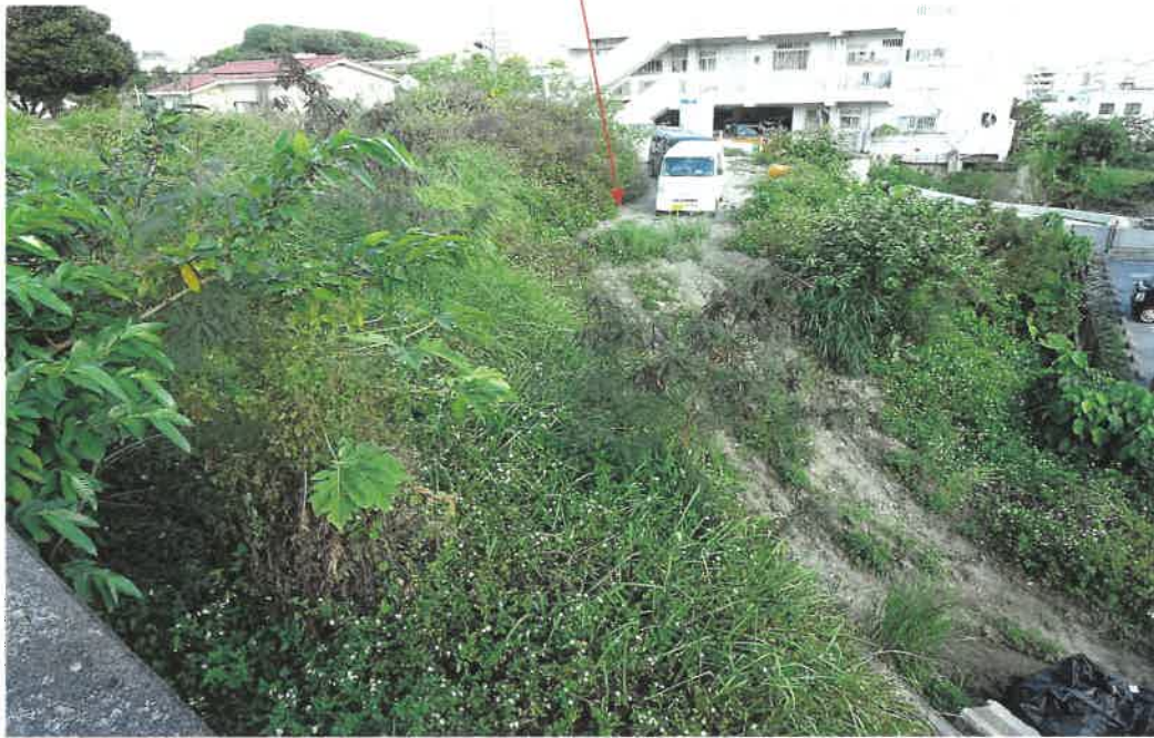
物件1(駐車場等として使用されている部分)
