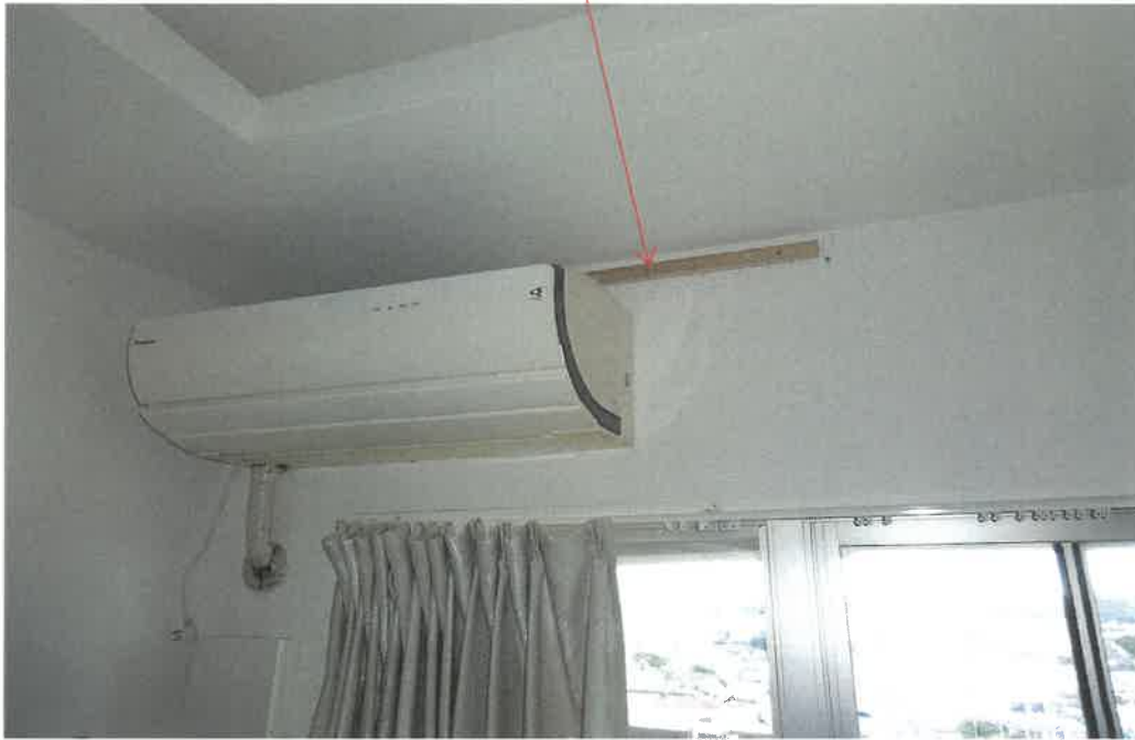
物件1の室内(仮止めされた壁の箇所)
