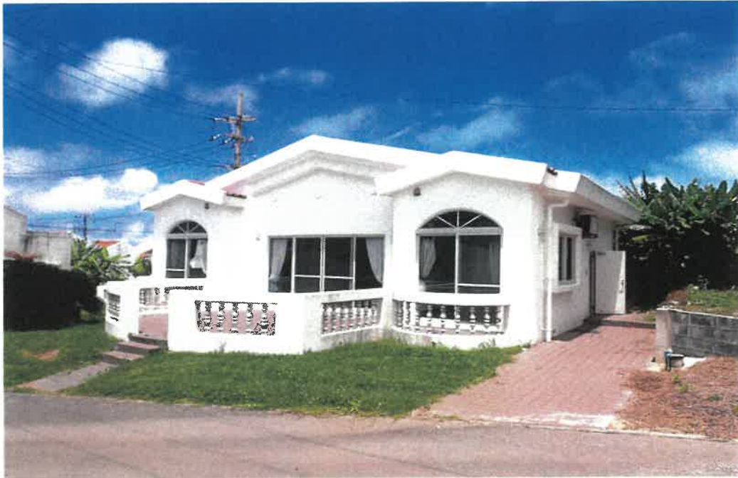
本件建物全景
