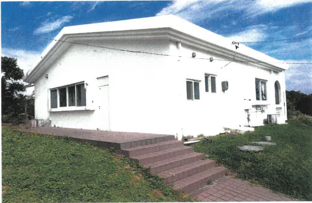
本件建物全景
