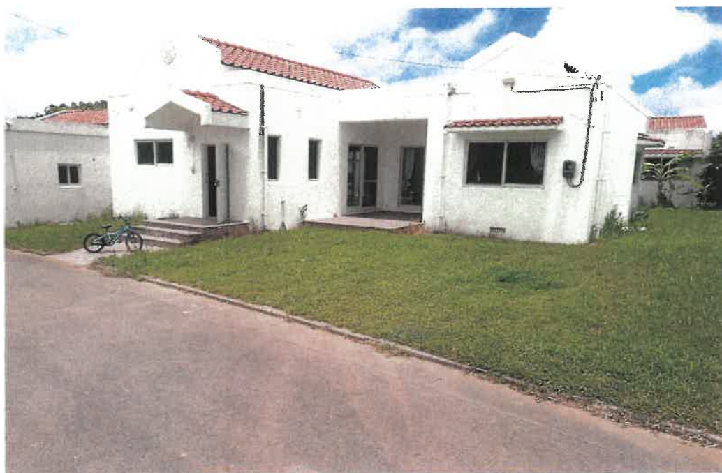
本件建物全景
