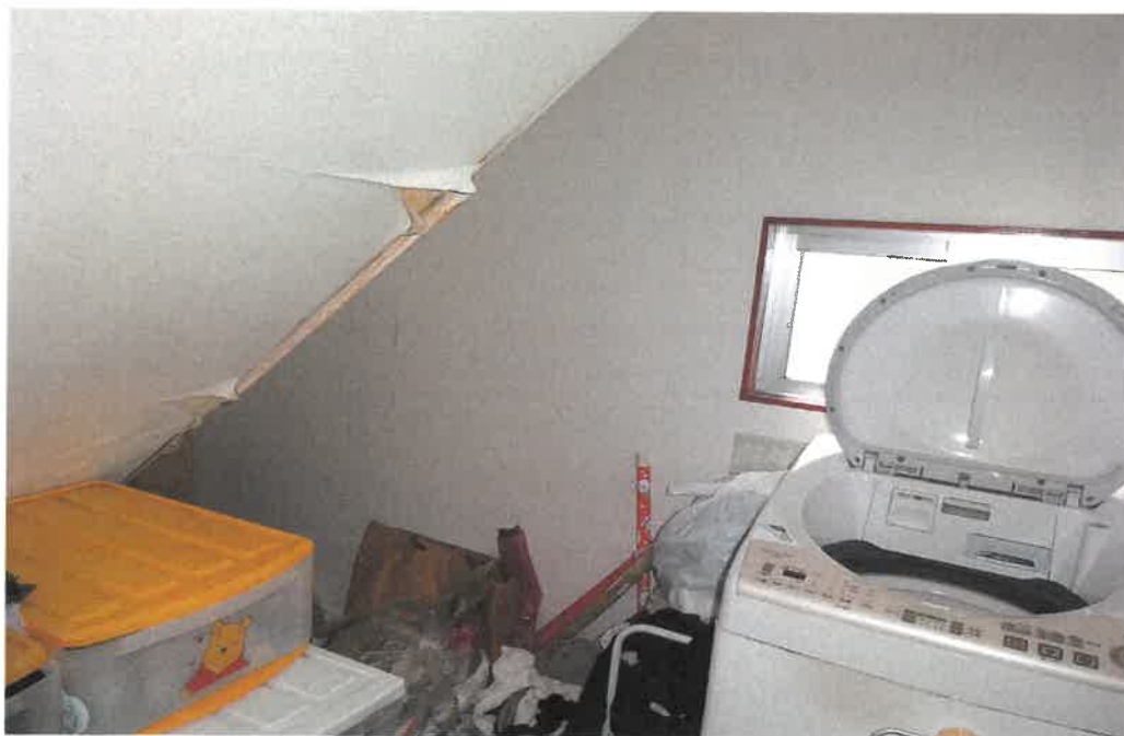
物件1の室内(増築部分)
