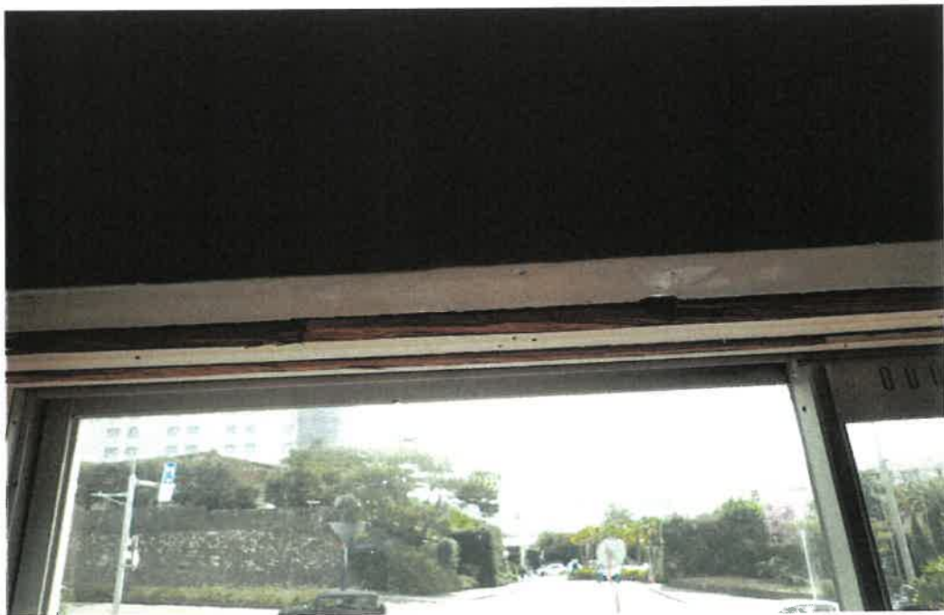
同上(シロアリによる被害状況)
