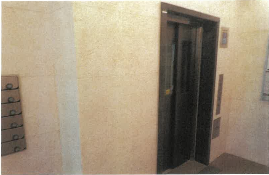
エレベーター付近の状況
