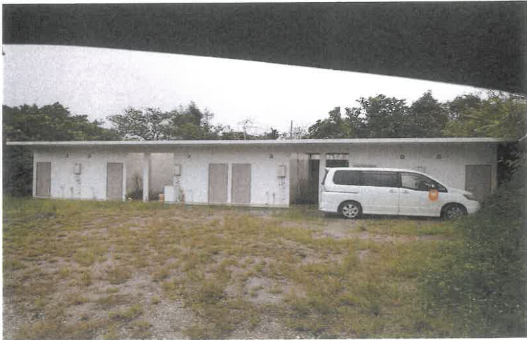
本件建物全景
