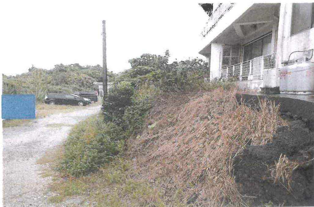
地役権が設定されている場所(電信柱と建物の間)の状況
