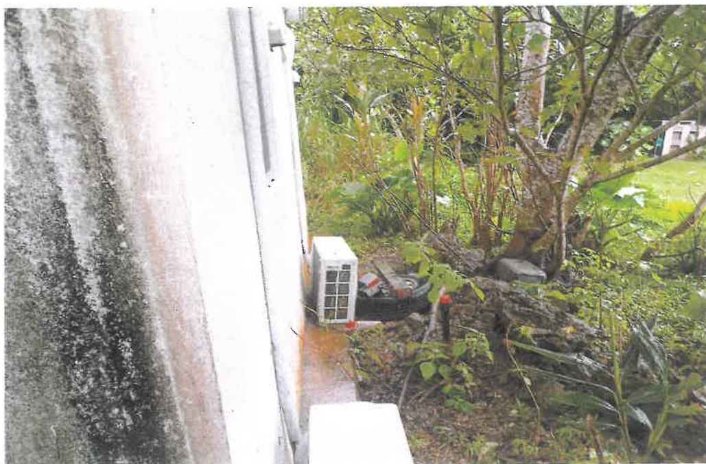
本件建物の裏側の状況
