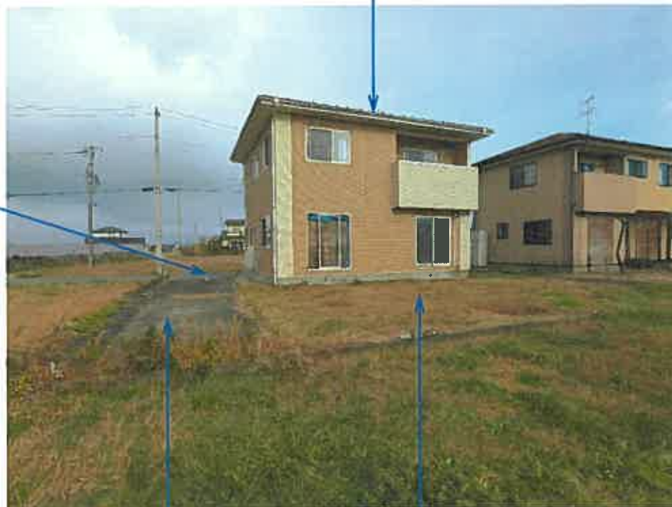
駐車スペース(コンクリート舗装) 物件 1
