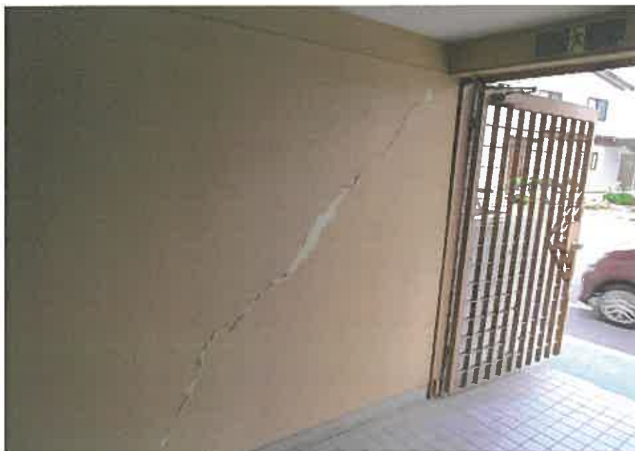
写真⑤ 以下、物件2の内部の状況
