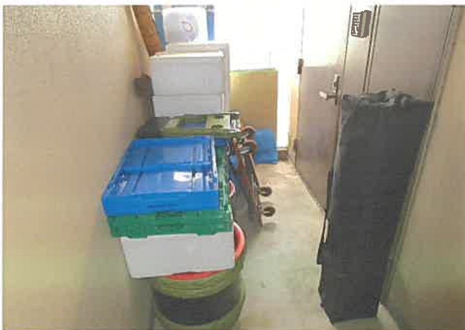
写真⑯ 204号室前の廊下
