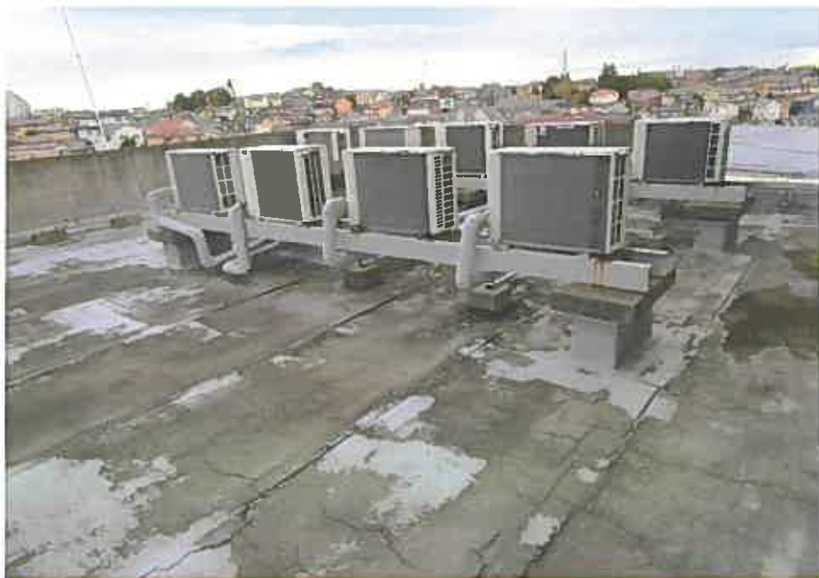
写真④ 屋上防水シートの状況
